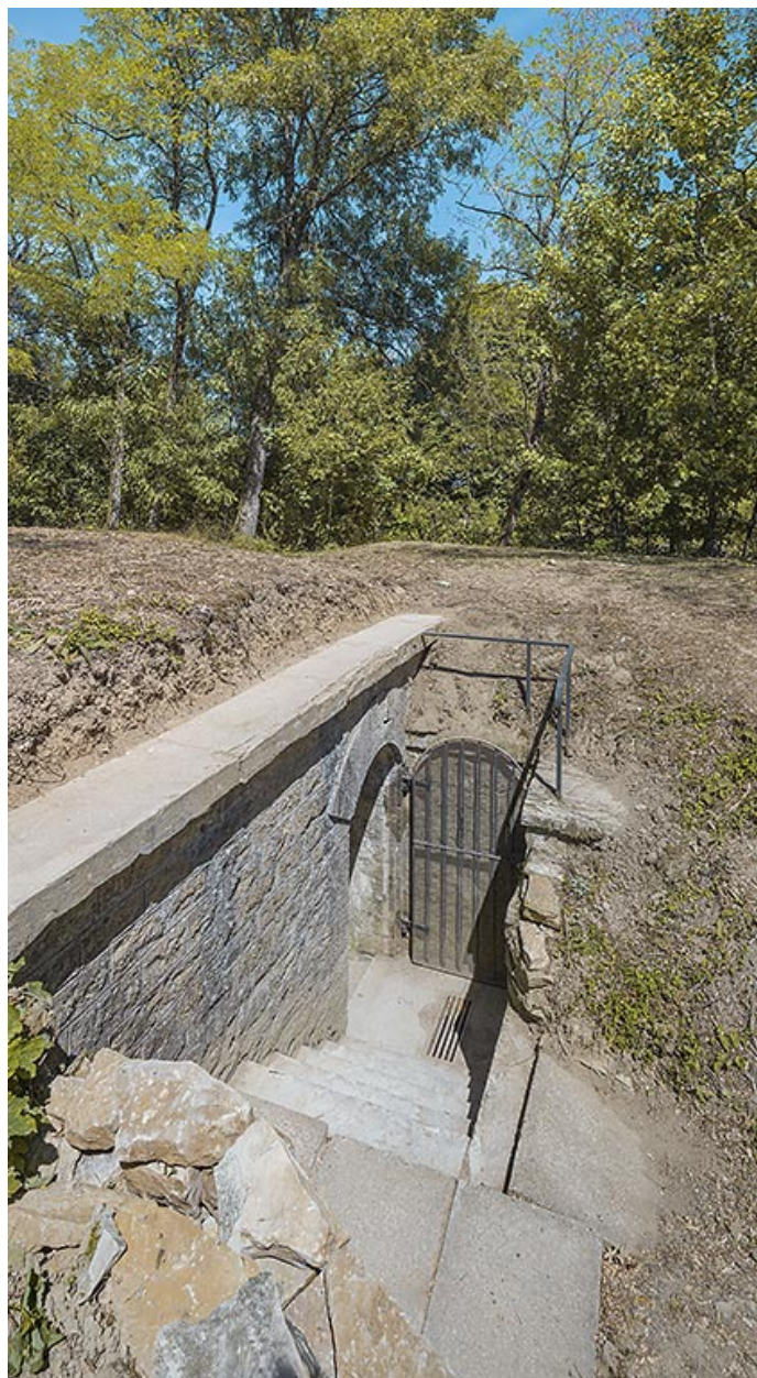
Porte d'accès à la caserne depuis les plateformes de tir du front de gorge.
