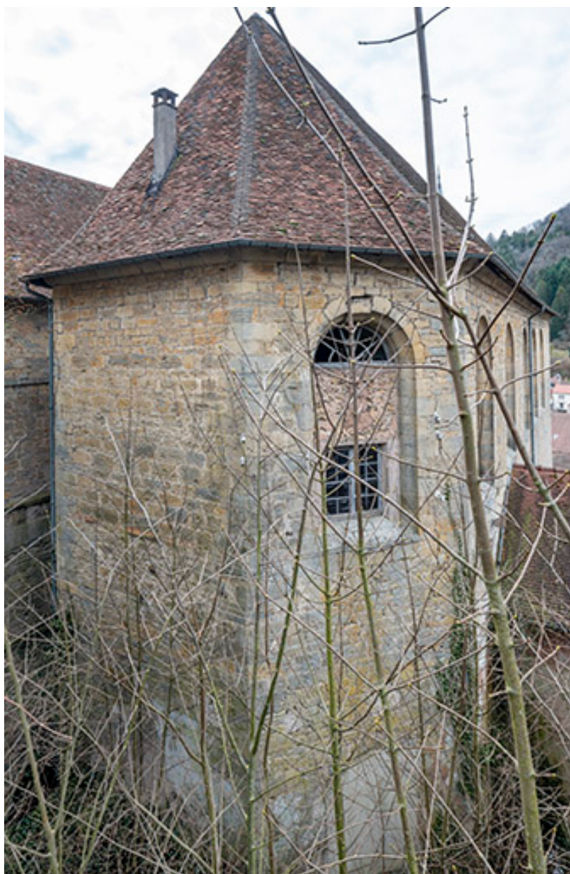
Chevet de la chapelle, depuis le nord.
