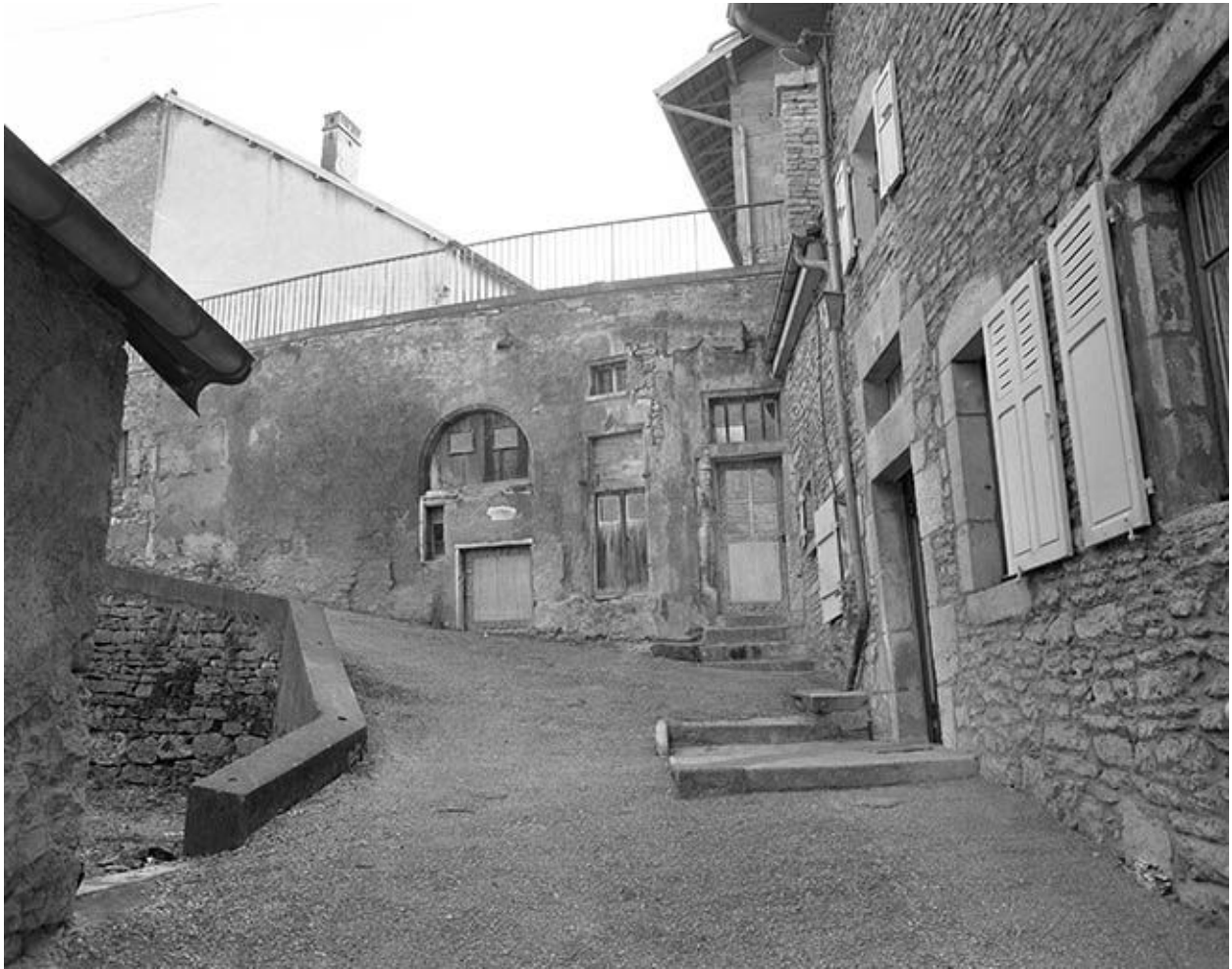
Vue d'ensemble des élévations rue du Charri.
