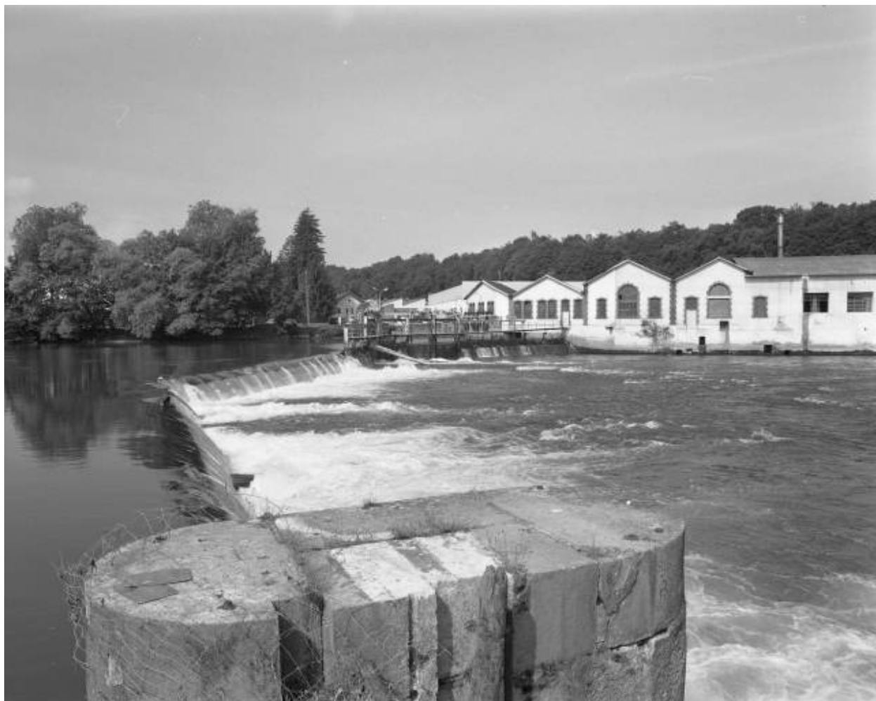
Vue d'ensemble depuis le pont.
