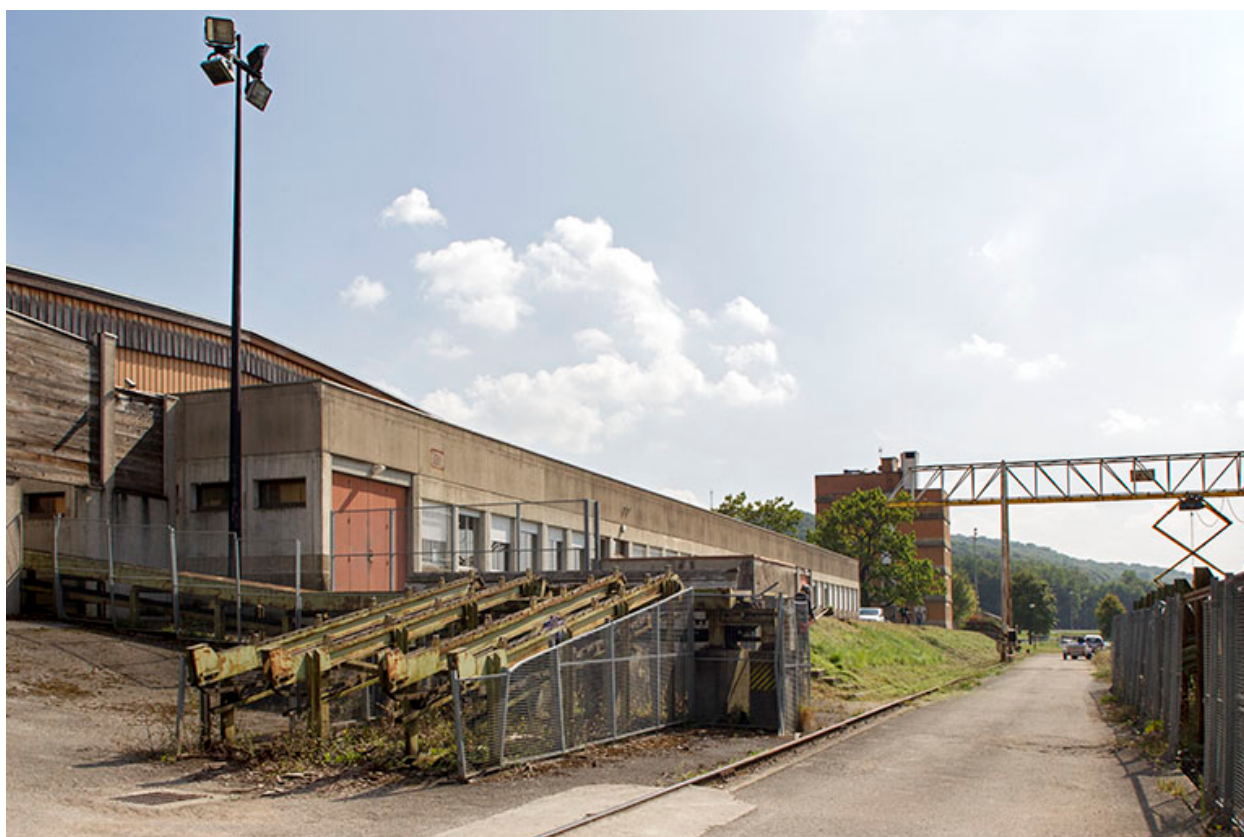
Atelier : façade ouest.
