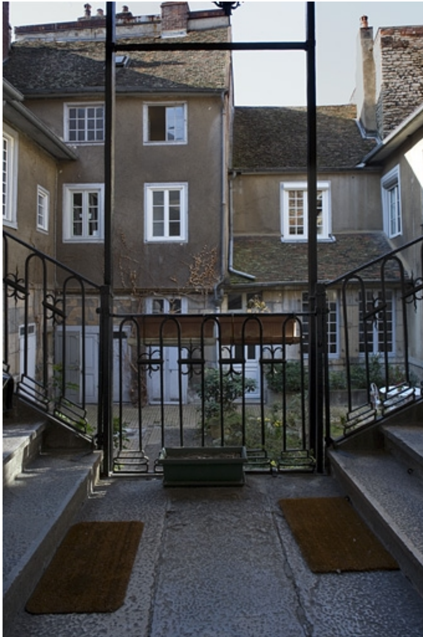
Vue des bâtiments en fond de cour depuis le premier palier de l'escalier.
