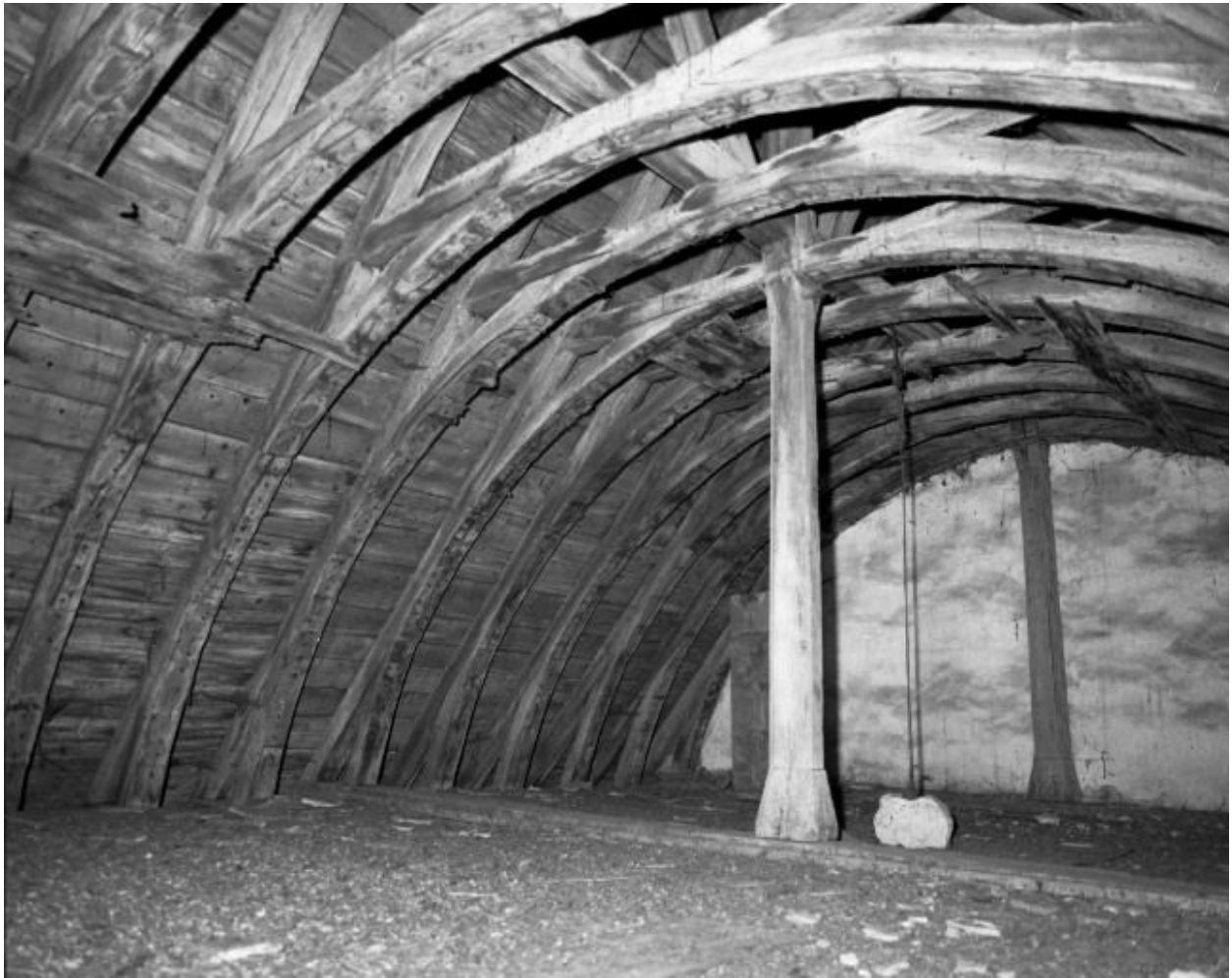
Comble du choeur, partie gauche.
