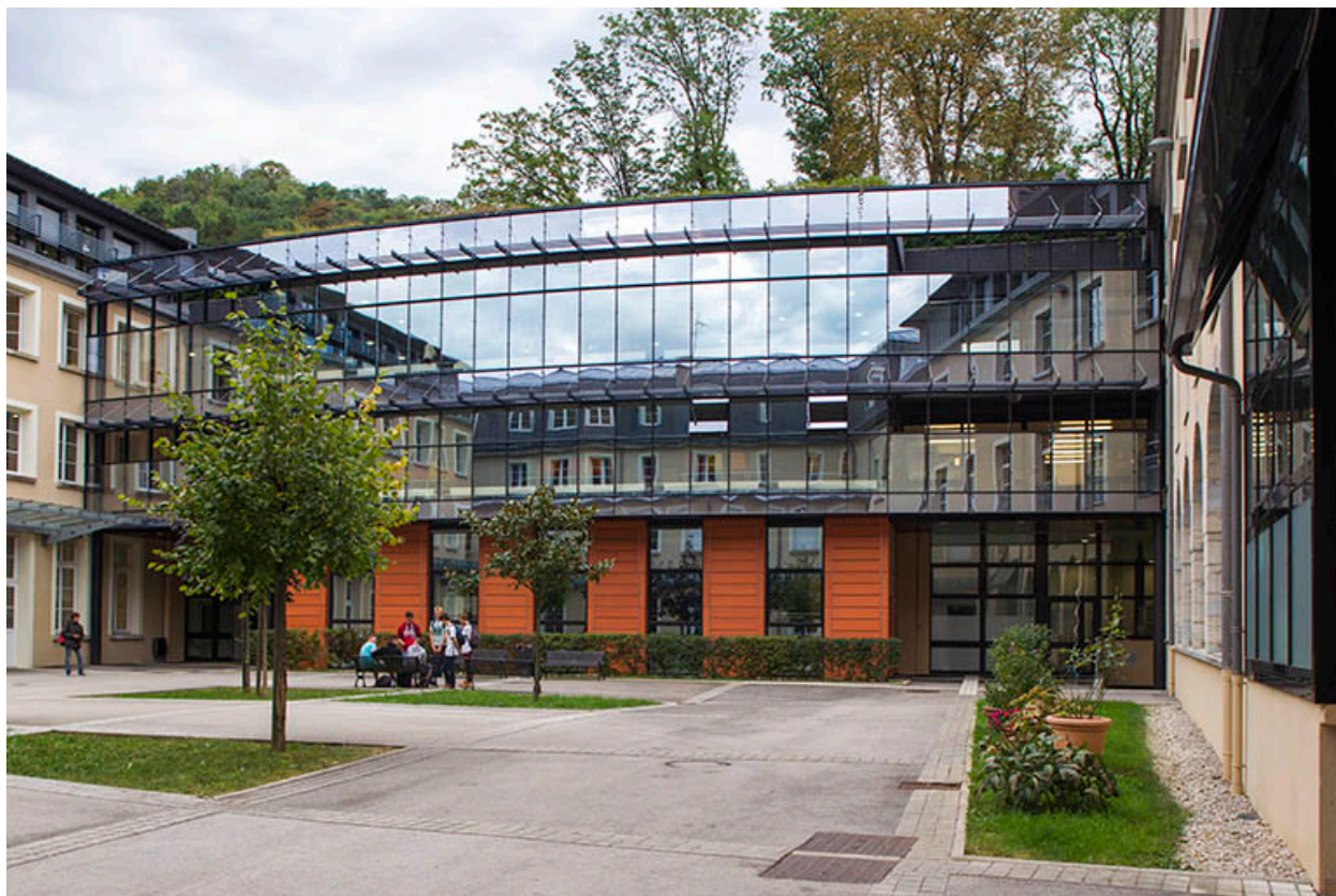
Aile Est : façade antérieure sur cour.
