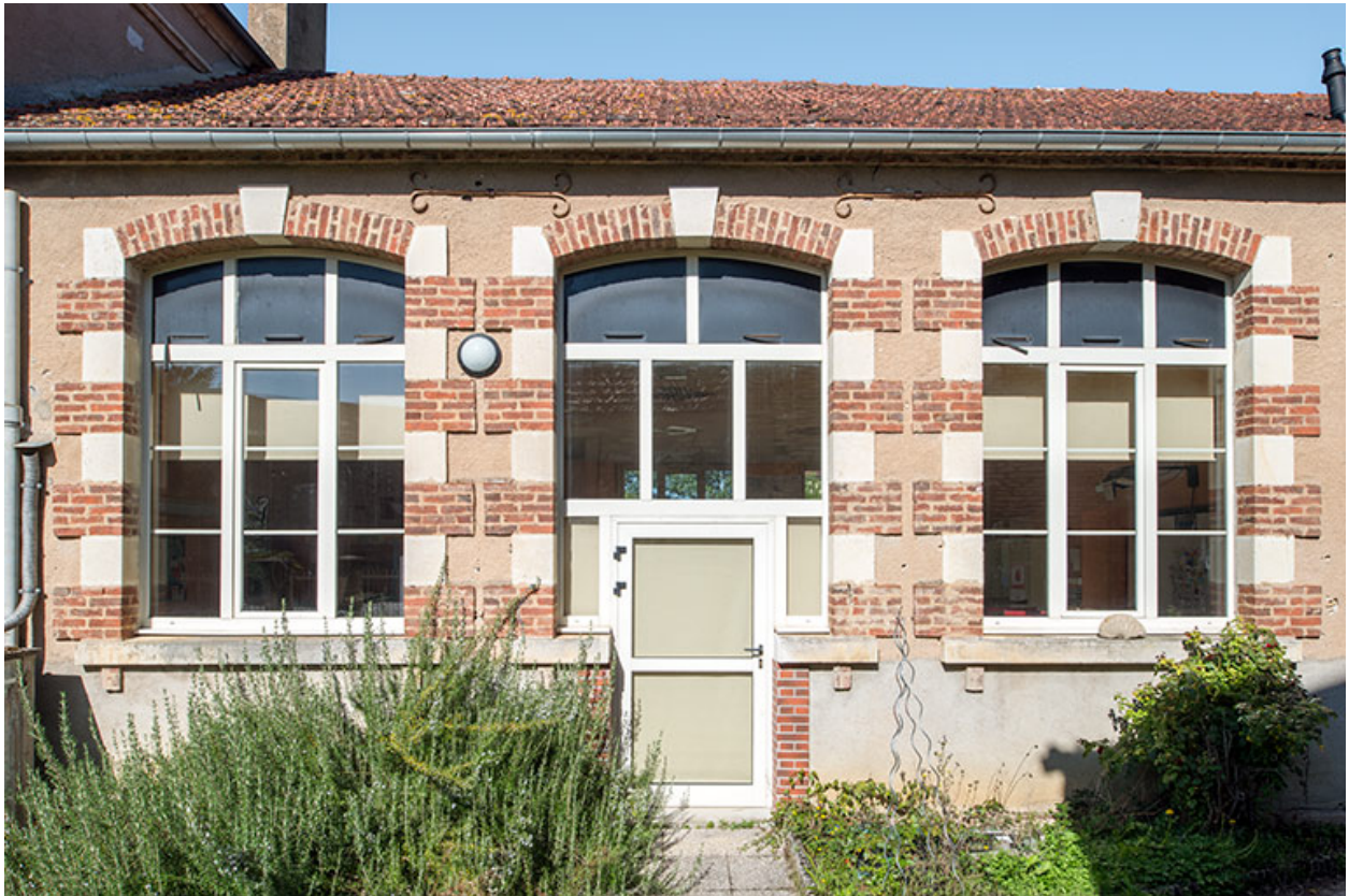
L'ancienne salle de classe, face sud.
