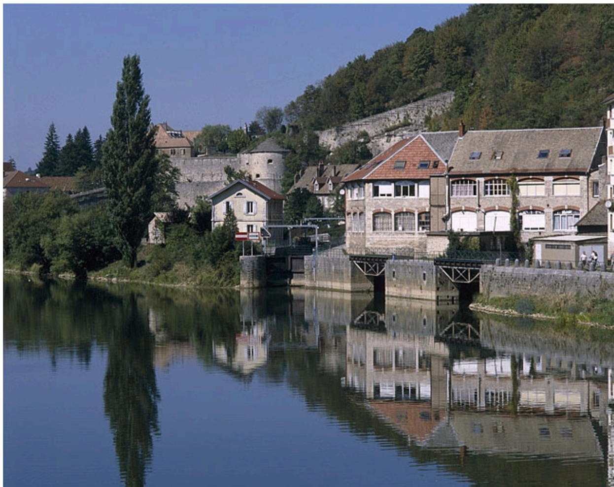
Besançon : maison d'éclusier n° 51 de Tarragnoz.
