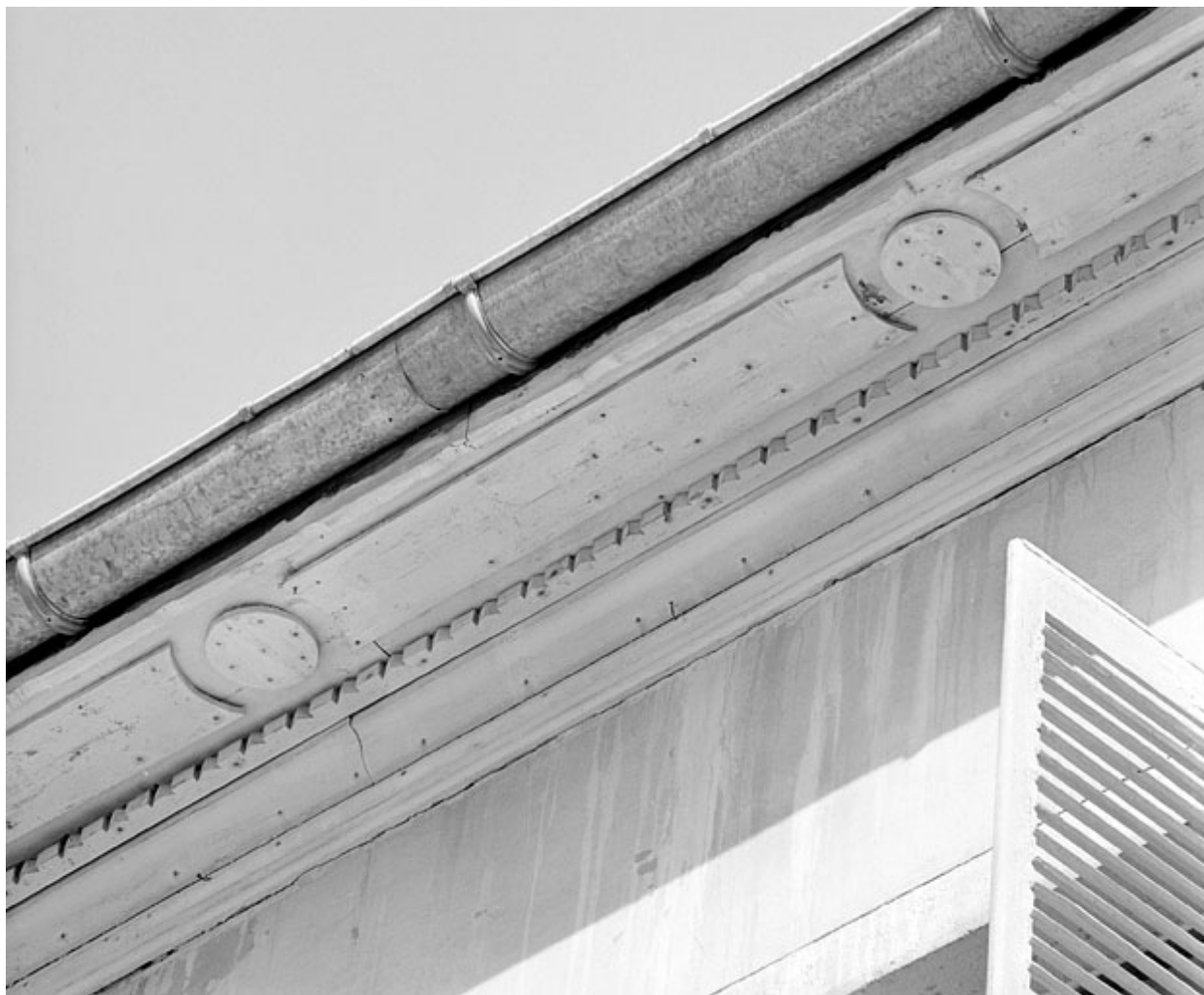
Détail de la corniche.
