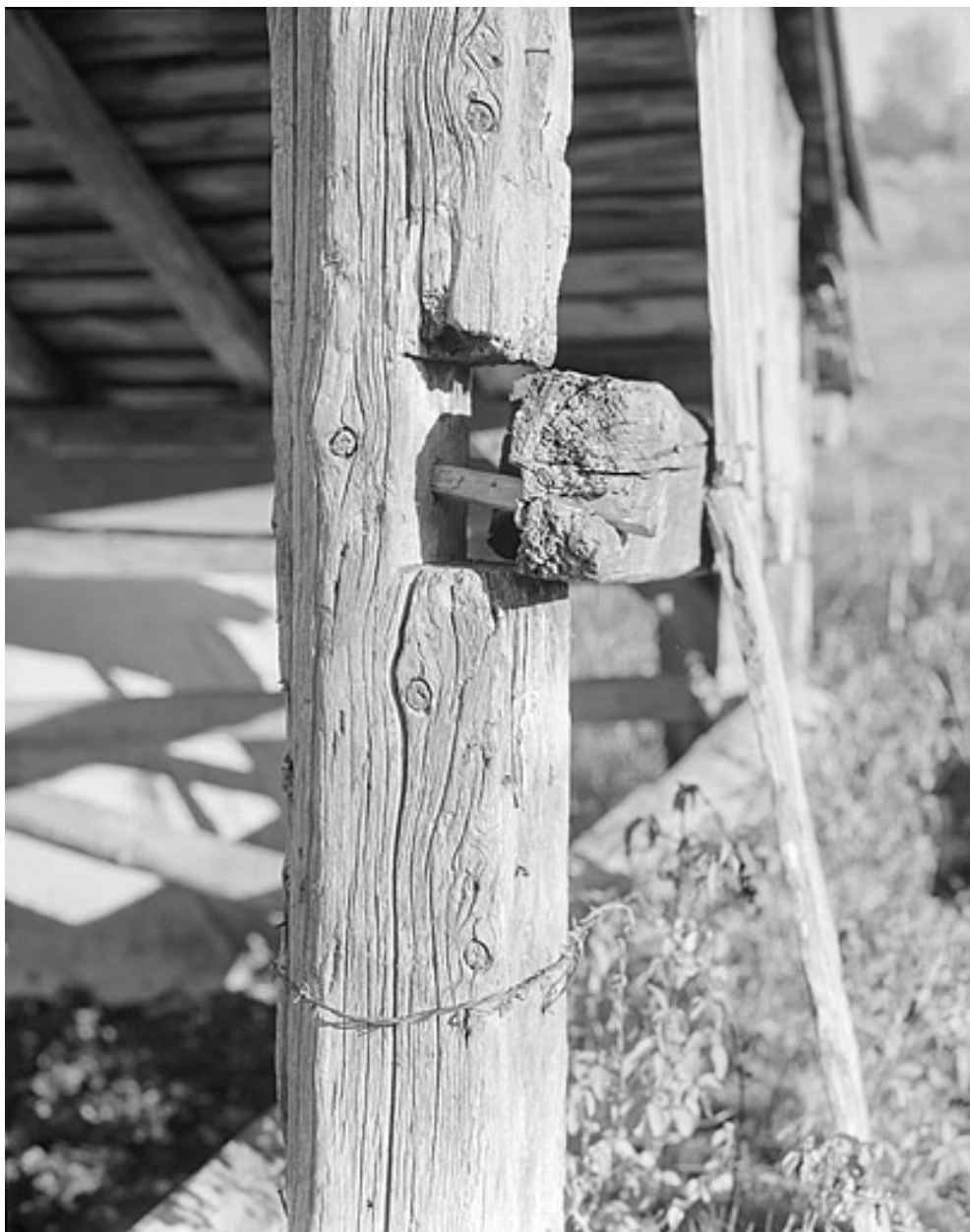
Assemblage à mi-bois poteaux-panne par une cheville.
