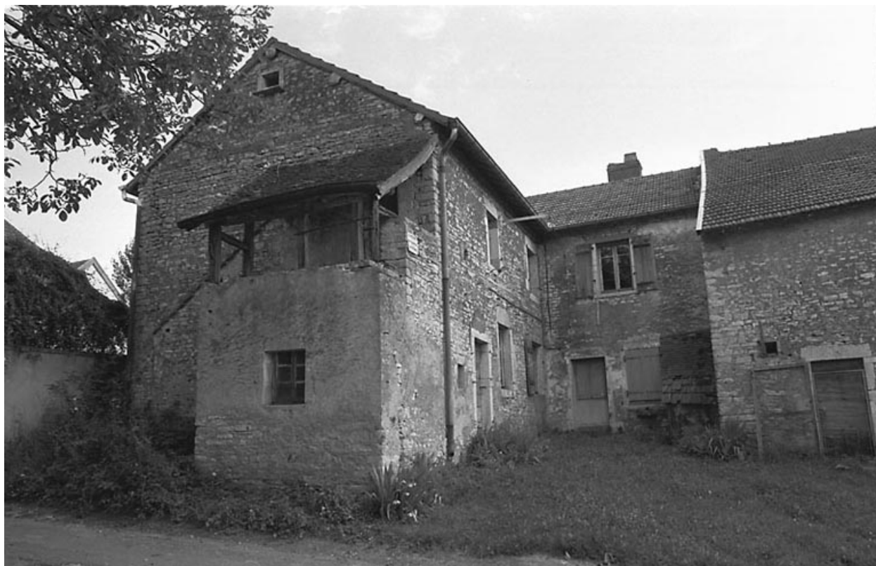
Partie gauche : habitation avec escalier extérieur.
