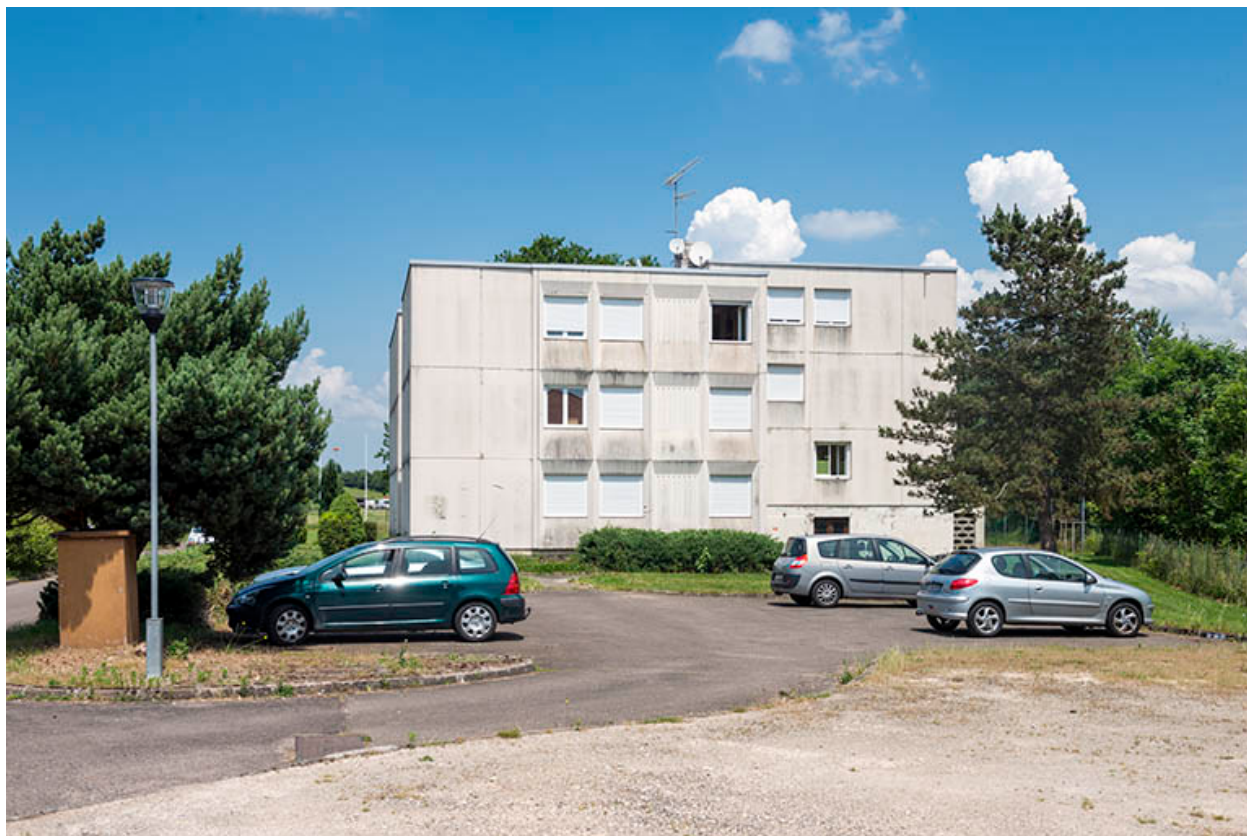
Façade sud des logements.
