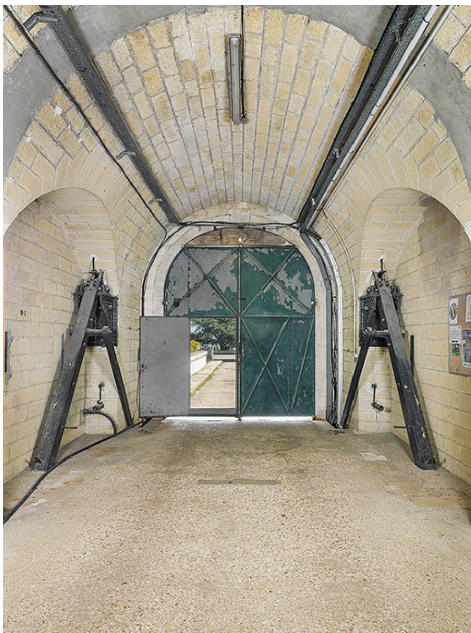
Le fort d'Hauteville : galerie d'entrée.
