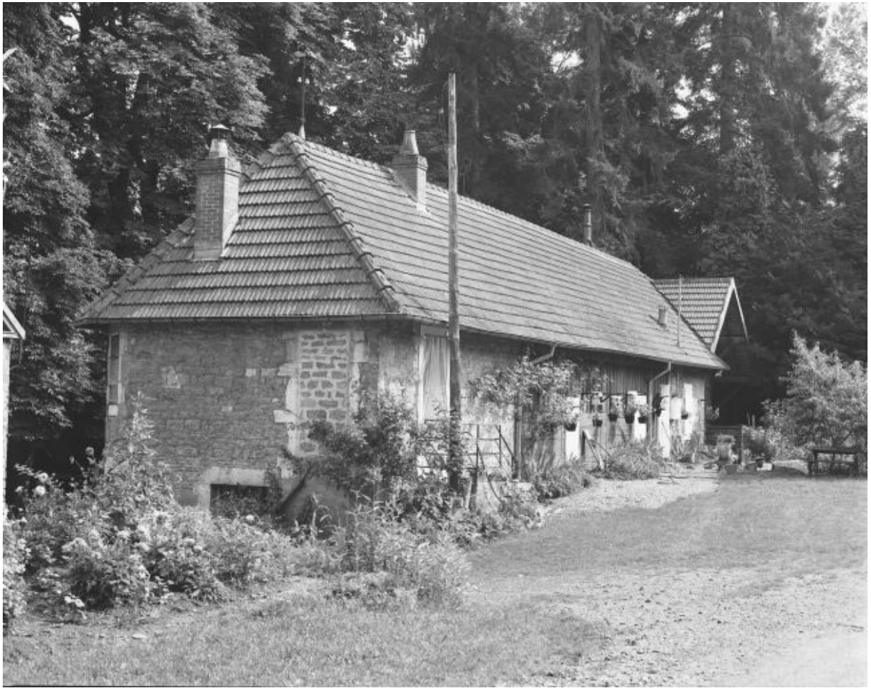
Logement ouvrier vu de trois quarts gauche.
