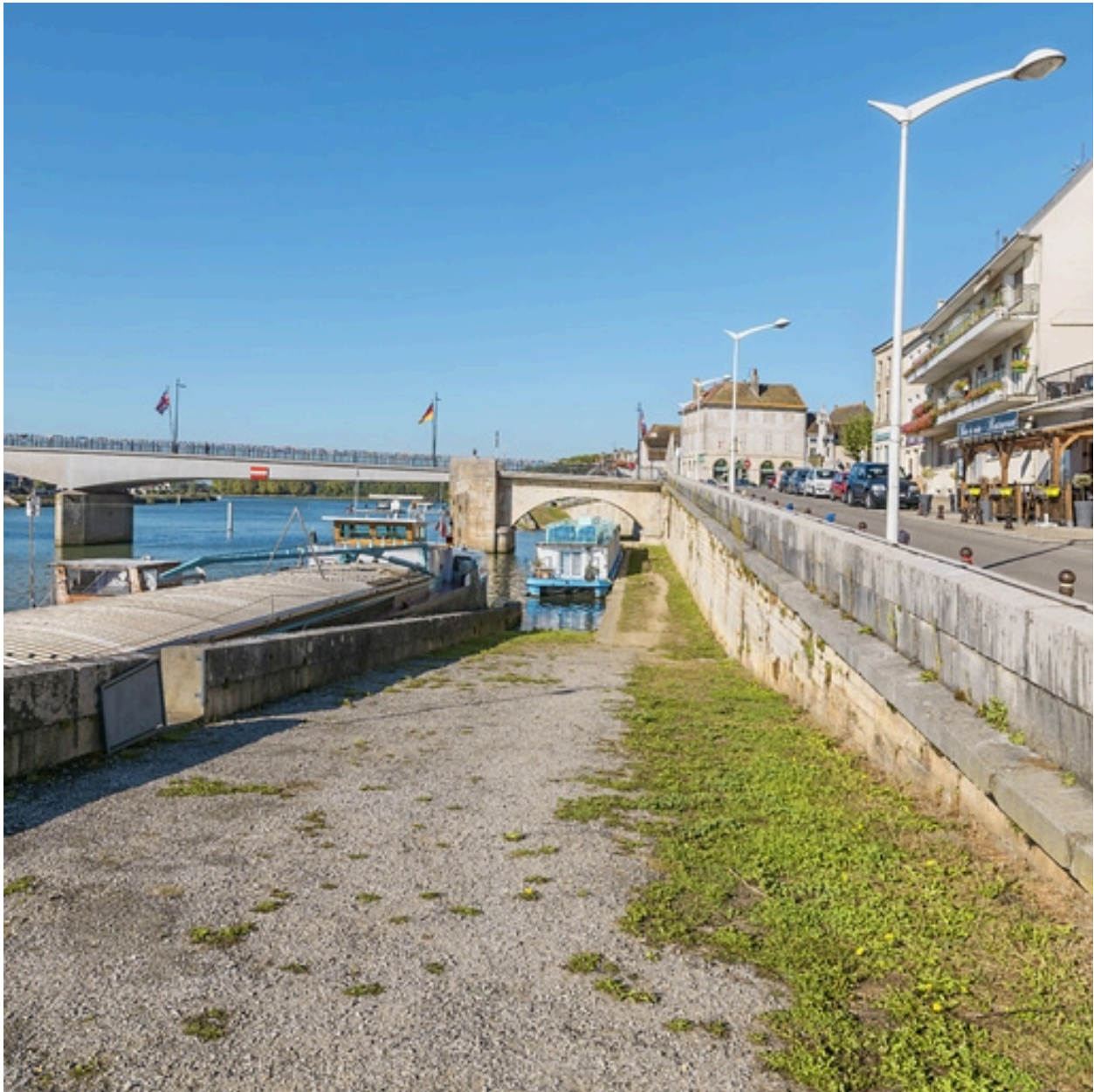
Arche maçonnée du pont, rive droite.
