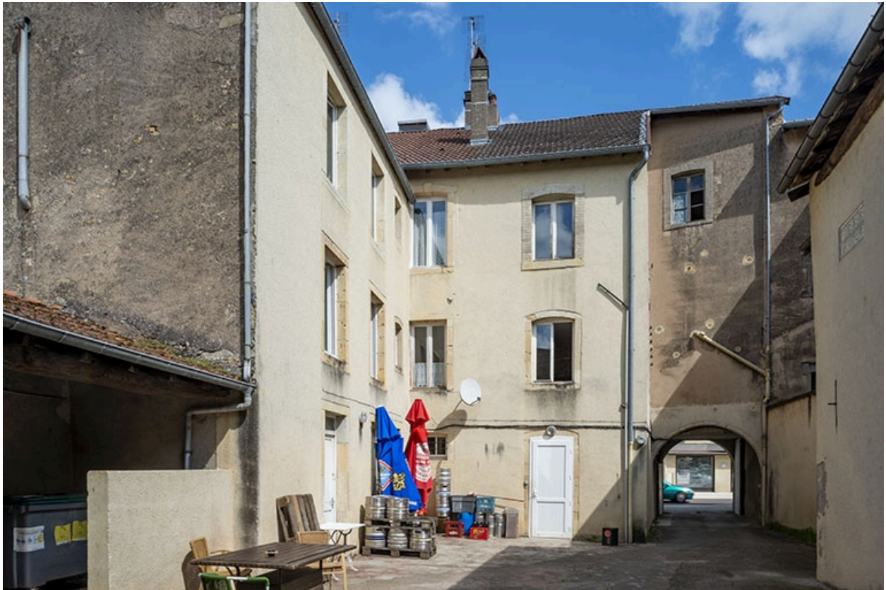
La rue Gambetta : n° 55, la cour et la façade postérieure.
