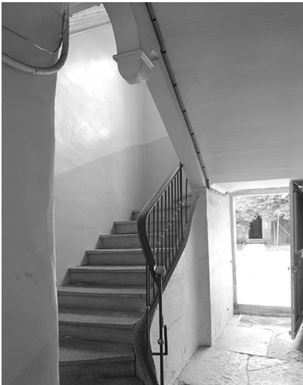
Escalier vu depuis le couloir.
