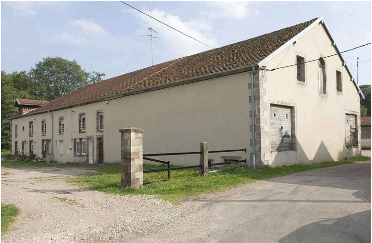
Entrepôt industriel (stockage des pommes de terre) vu de trois quarts.
