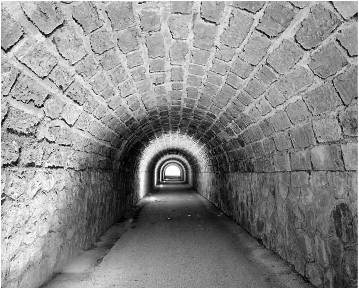
Passage souterrain (sous les voies) : intérieur.
