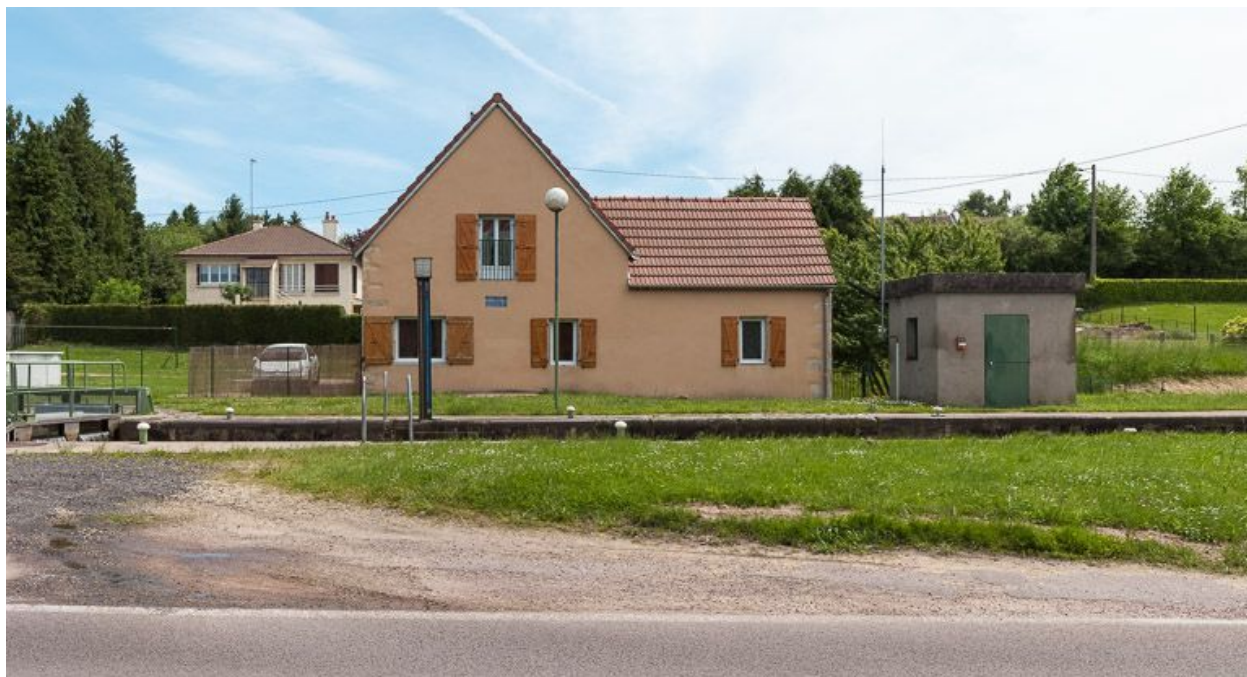
La maison éclusière vue de face.
