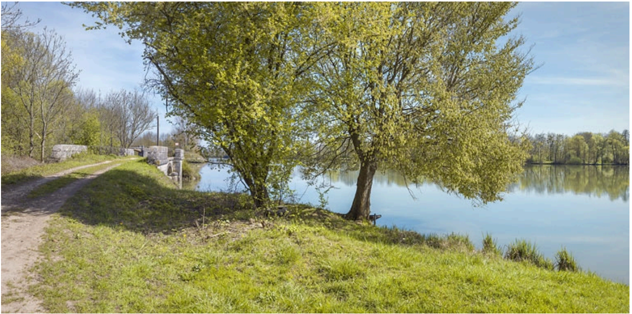
Vue d'ensemble, d'aval.
