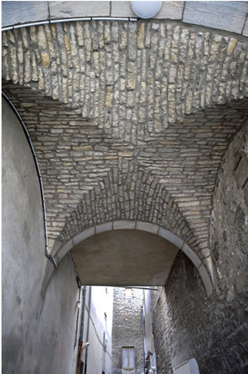
Détail de la voûte du passage au-dessus de l'ancien trage.
