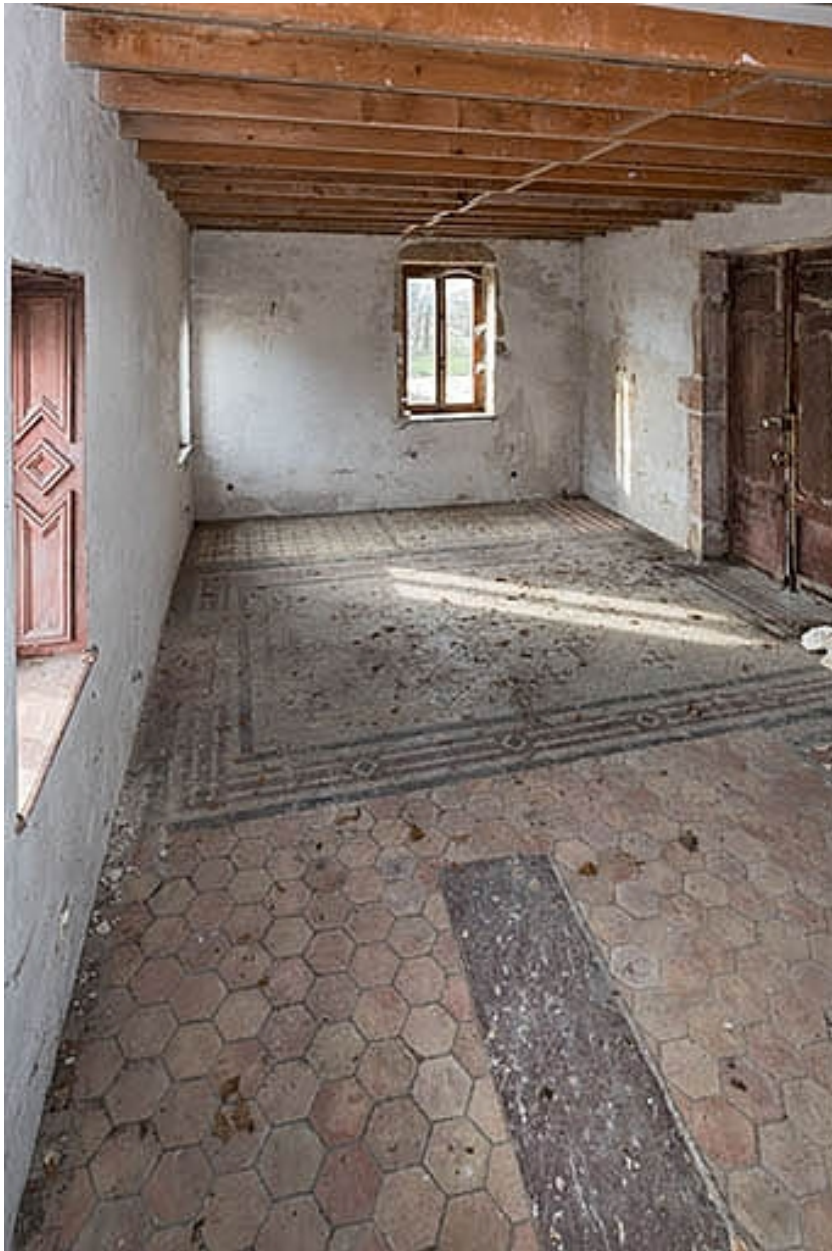
"Château neuf" : intérieur au rez-de-chaussée de l' "appartement des bains" (cadrage vertical).
