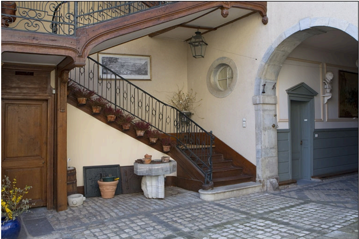
Détail du départ de l'escalier à cage ouverte.
