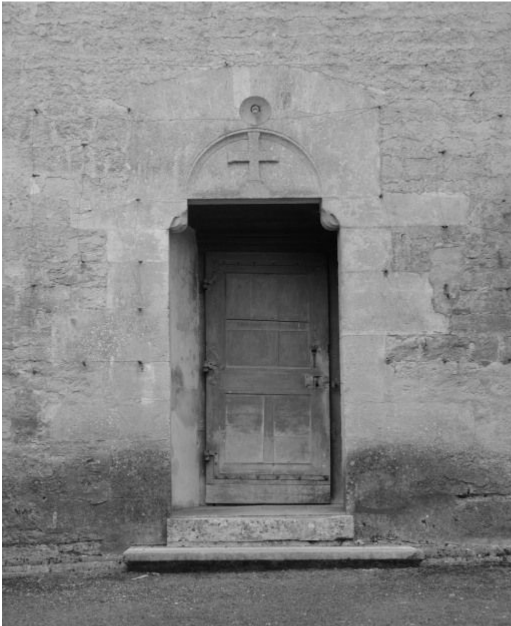
Eglise : élévation gauche, porte de la deuxième travée du bas-côté.
