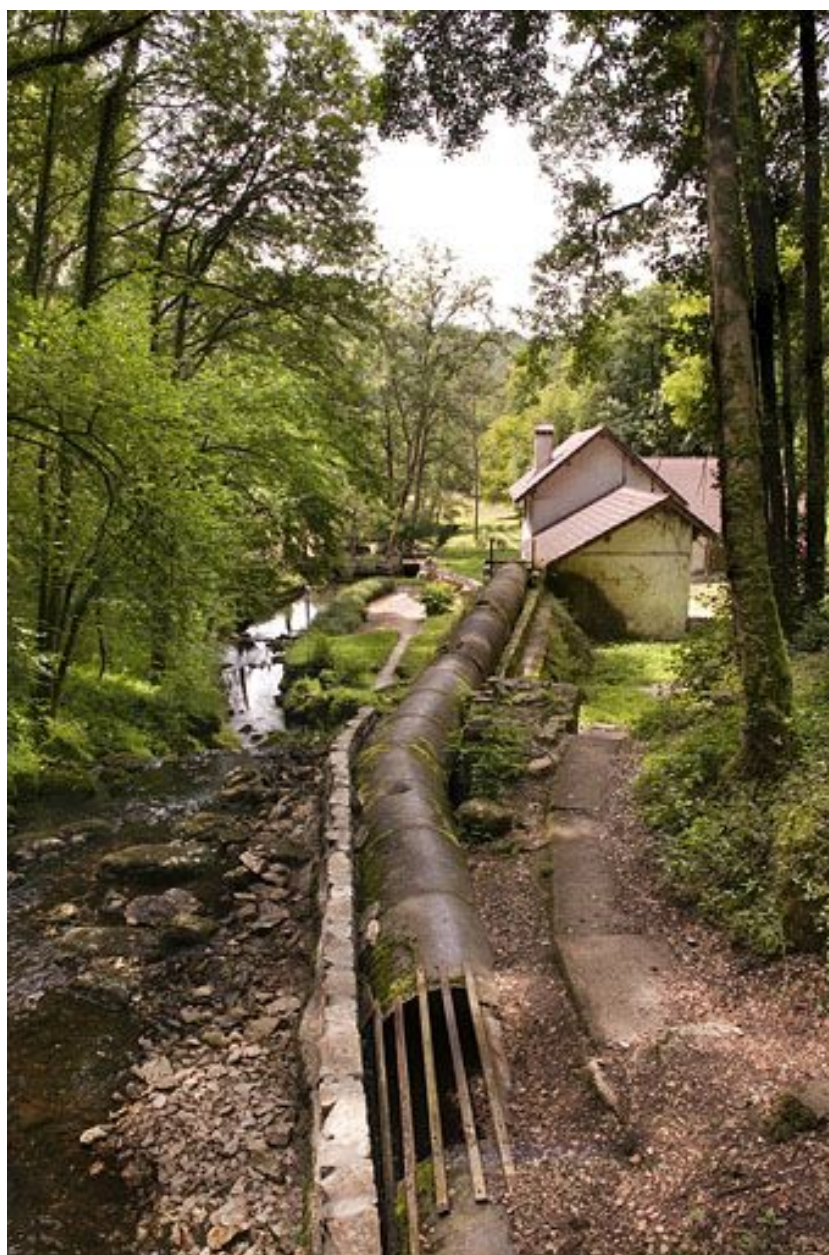
La conduite d'amenée.
