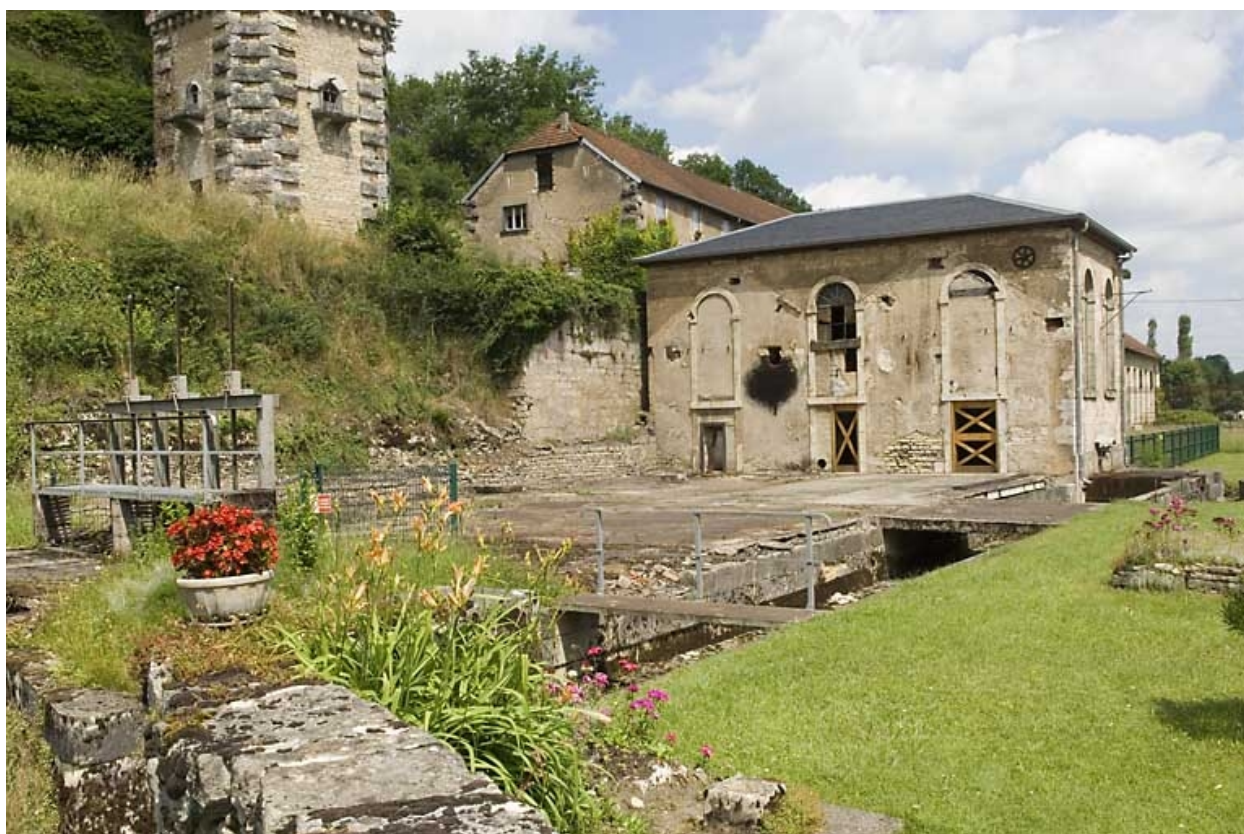
Salle des machines depuis l'est.
