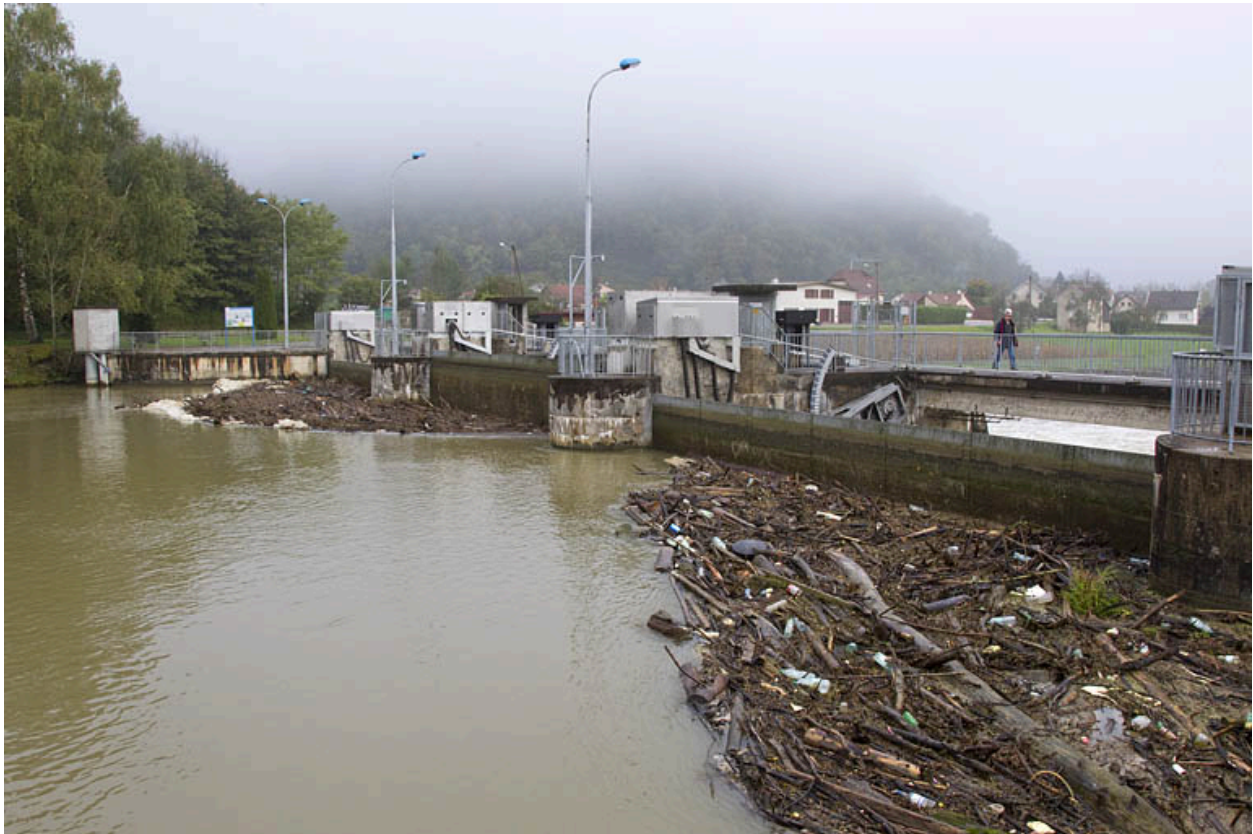
Retenue d'eau en amont du barrage.
