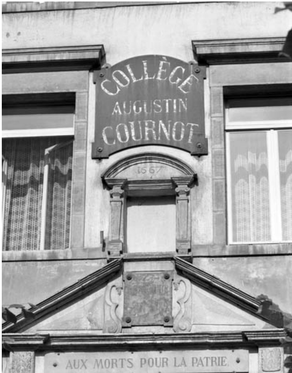
Façade antérieure du bâtiment principal : détail de la niche au dessus du portail d'entrée en 1989.
