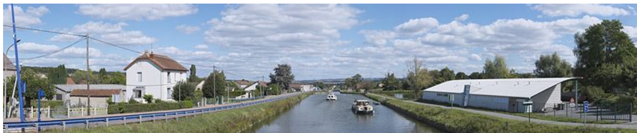
Echelle d'écluses depuis le pont sur l'écluse 01.
