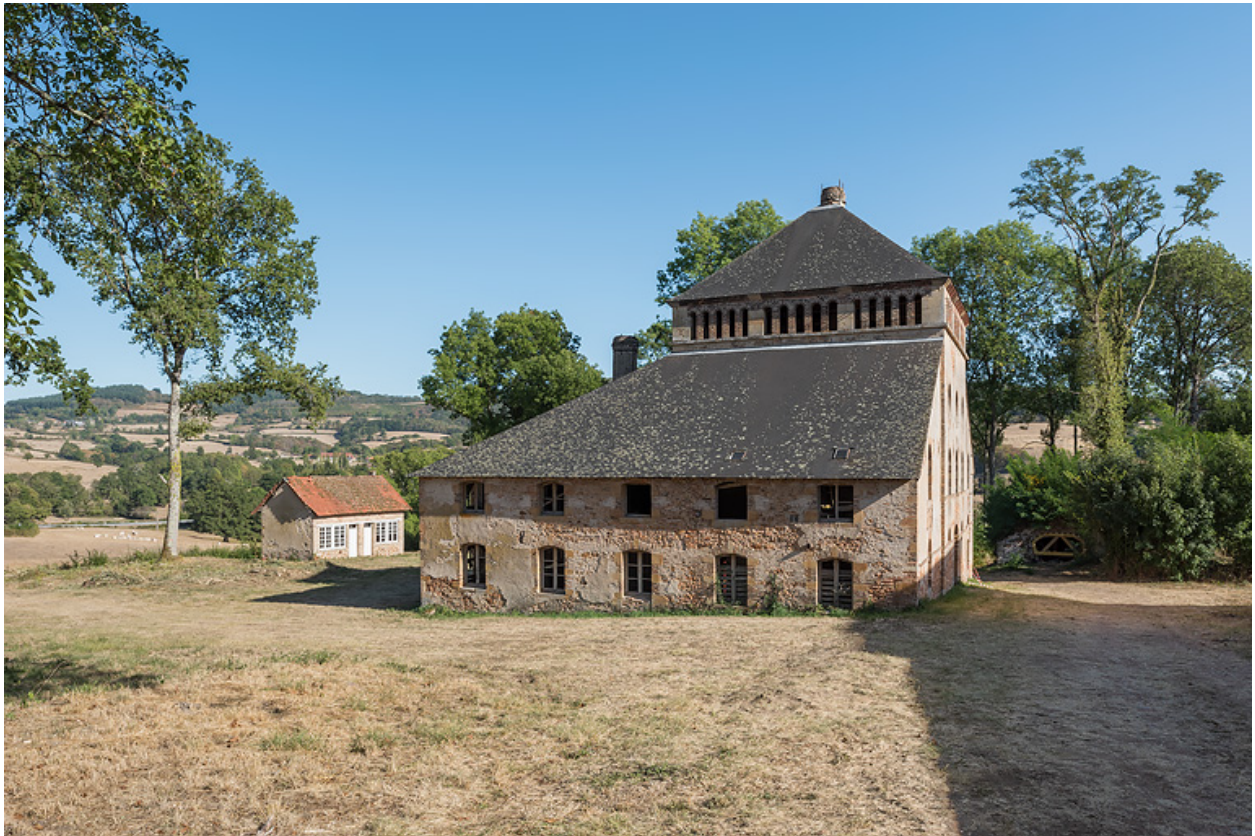
Vue depuis le nord-ouest, état actuel.
