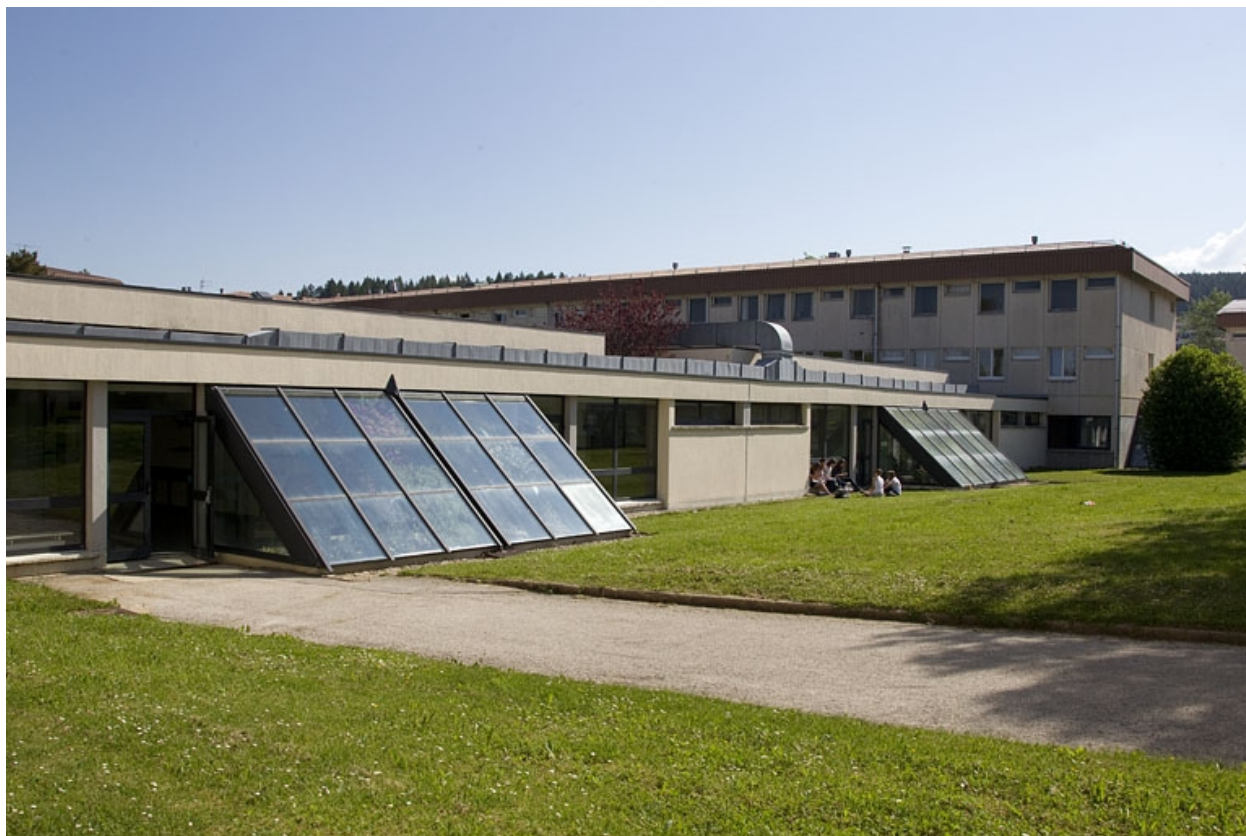
Bâtiment de la restauration : face sud.
