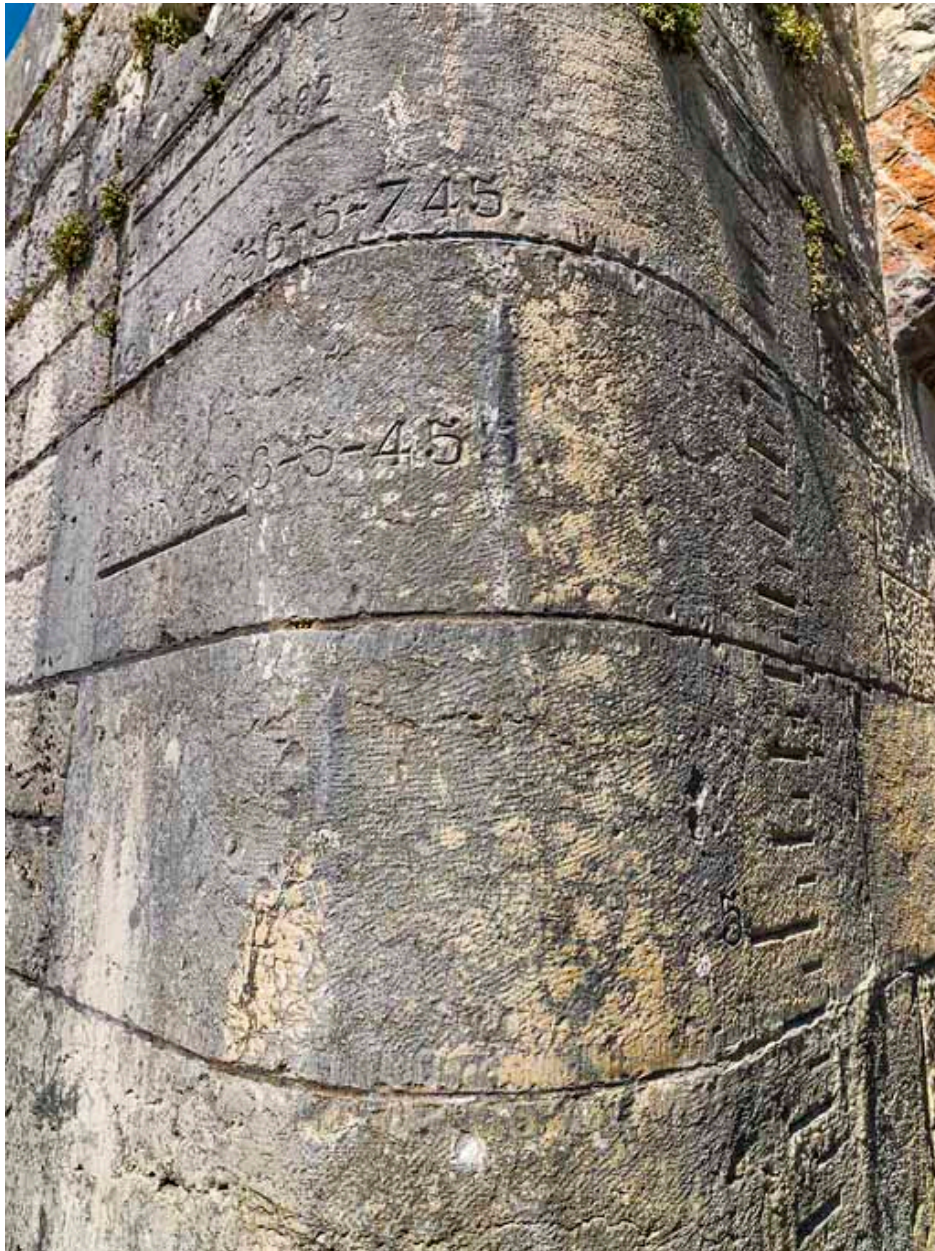
Détail de l'échelle de crue sur la culée du pont.
