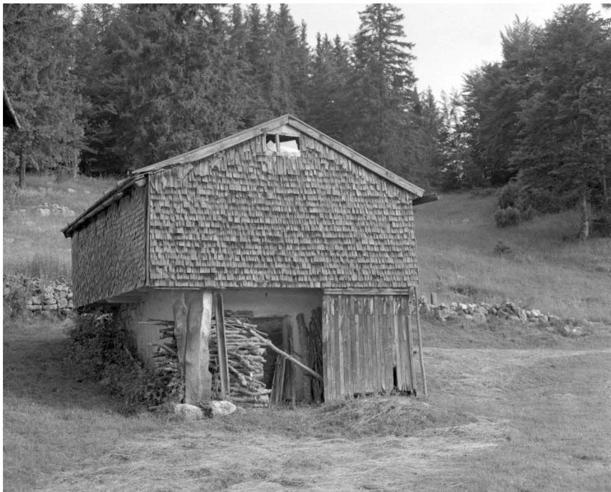
La resserre avec un accès en soubassement.
