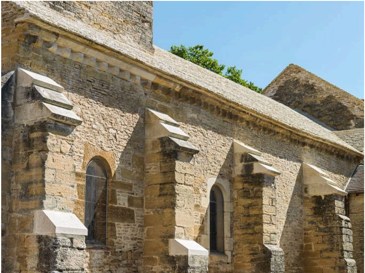
Elévation sud-ouest, détail des contreforts et de la corniche.
