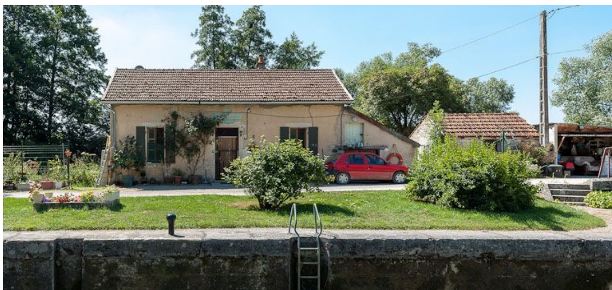
Maison éclusière, vue de face.
