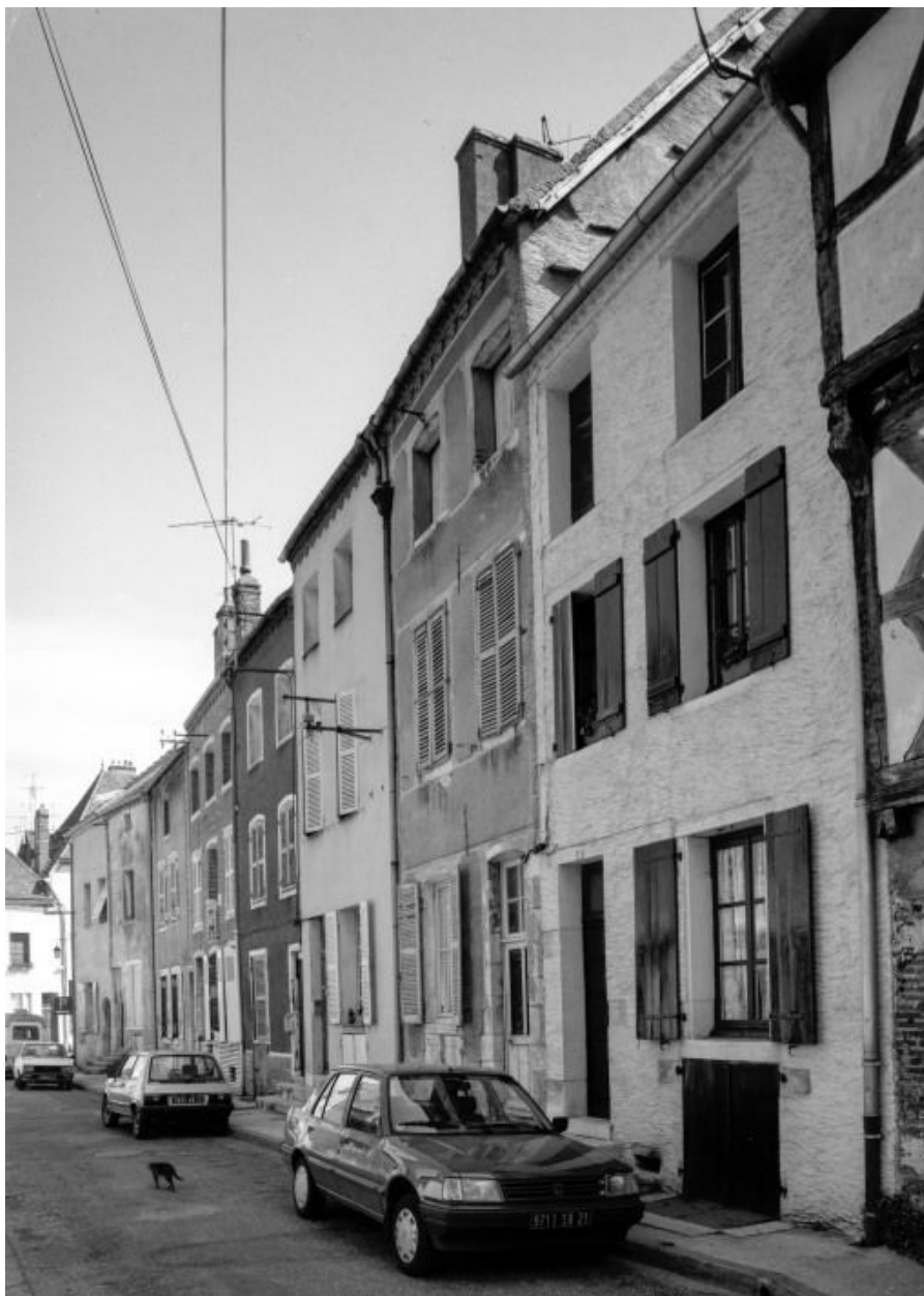
Alignement de maisons, n° 18 à 32 rue Dulac.
