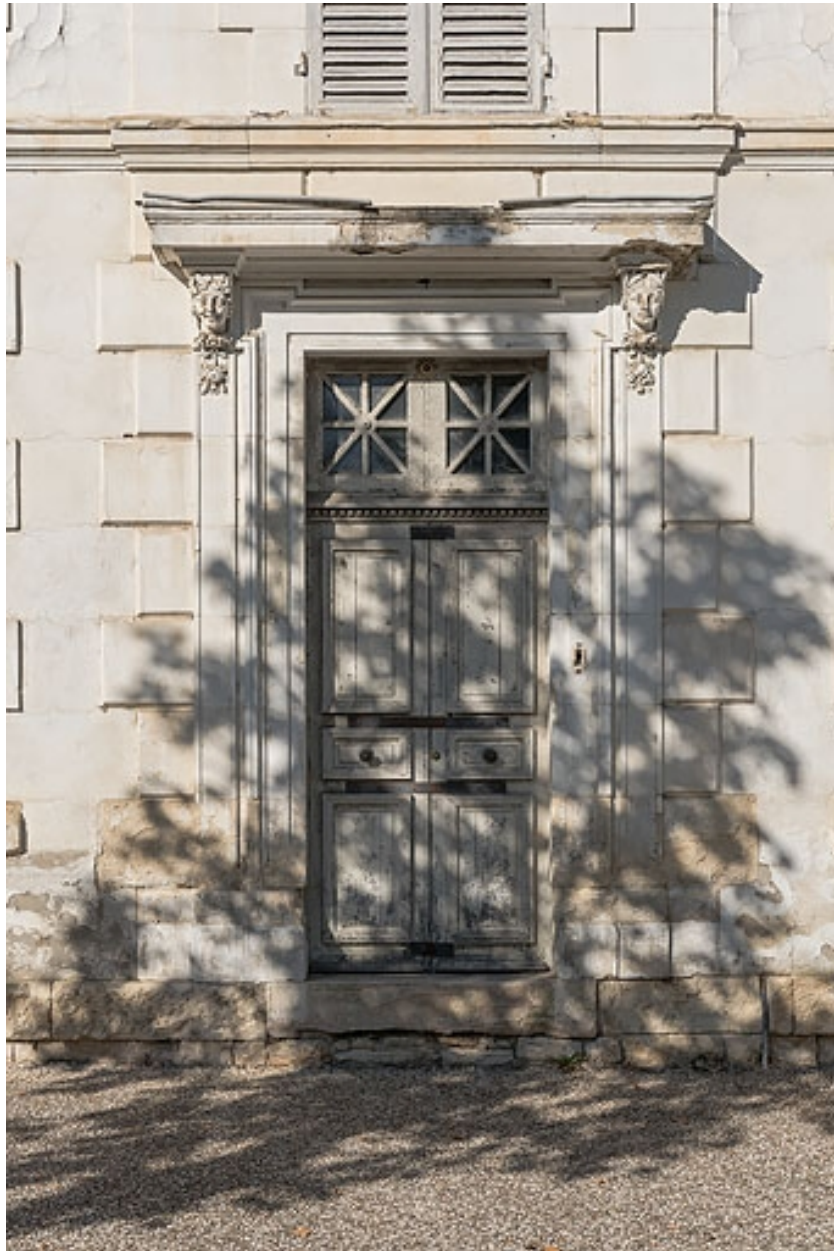
Façade de la maison de Marien dit Georges Bigouret, porte d'entrée.
