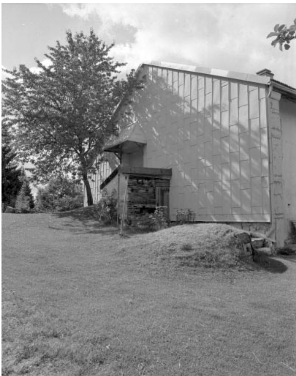
Face gauche recouverte d'un essentage de zinc.
