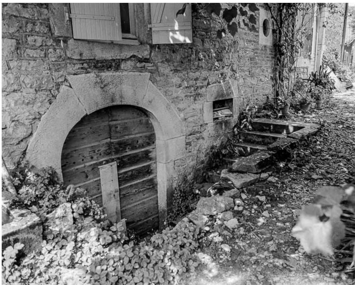
Bâtiment d'habitation : l'entrée de cave sur la façade postérieure.
