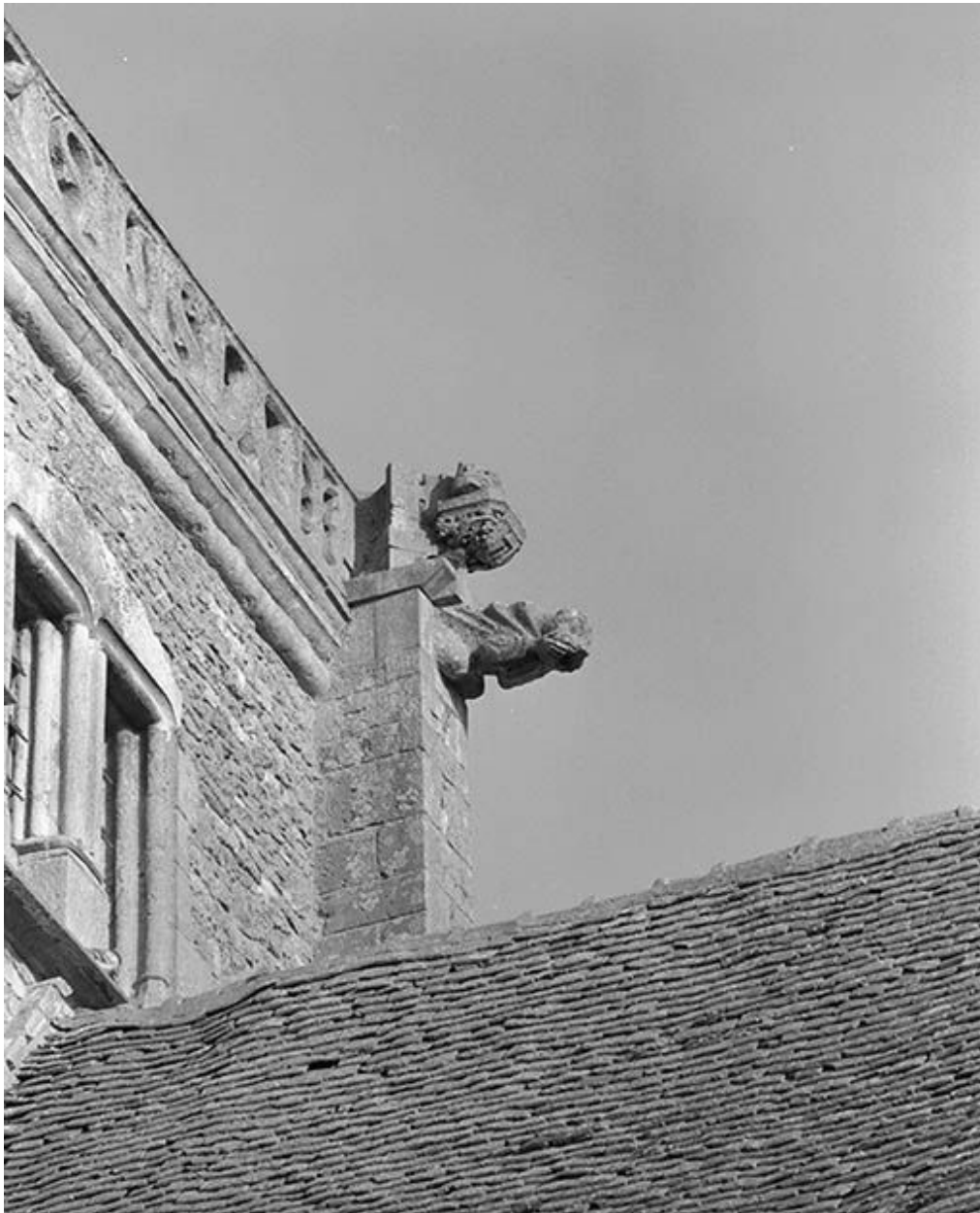
Clocher, angle postérieur gauche, côté nord.
