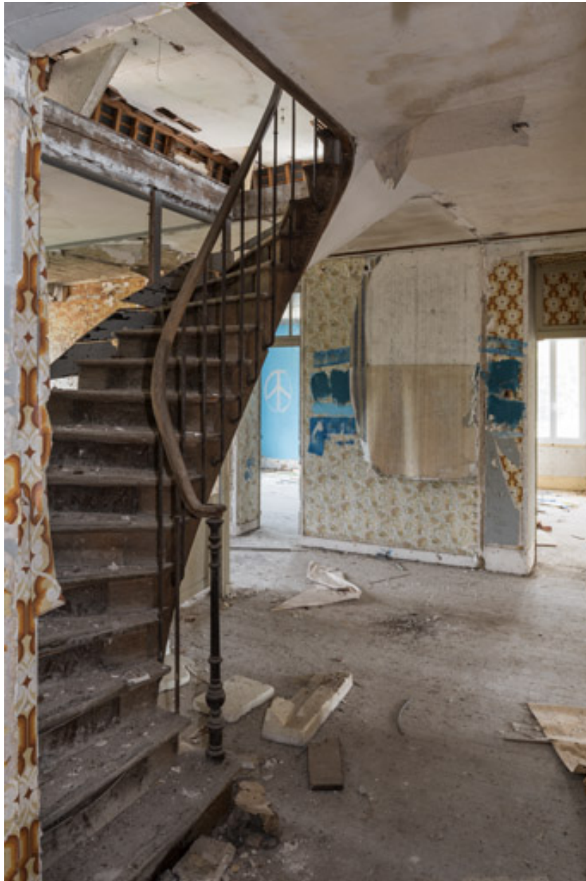
Escalier secondaire conduisant du deuxième au troisième étage du pavillon est.
