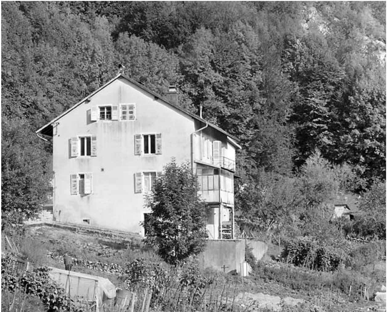
Façades latérale droite et postérieure.
