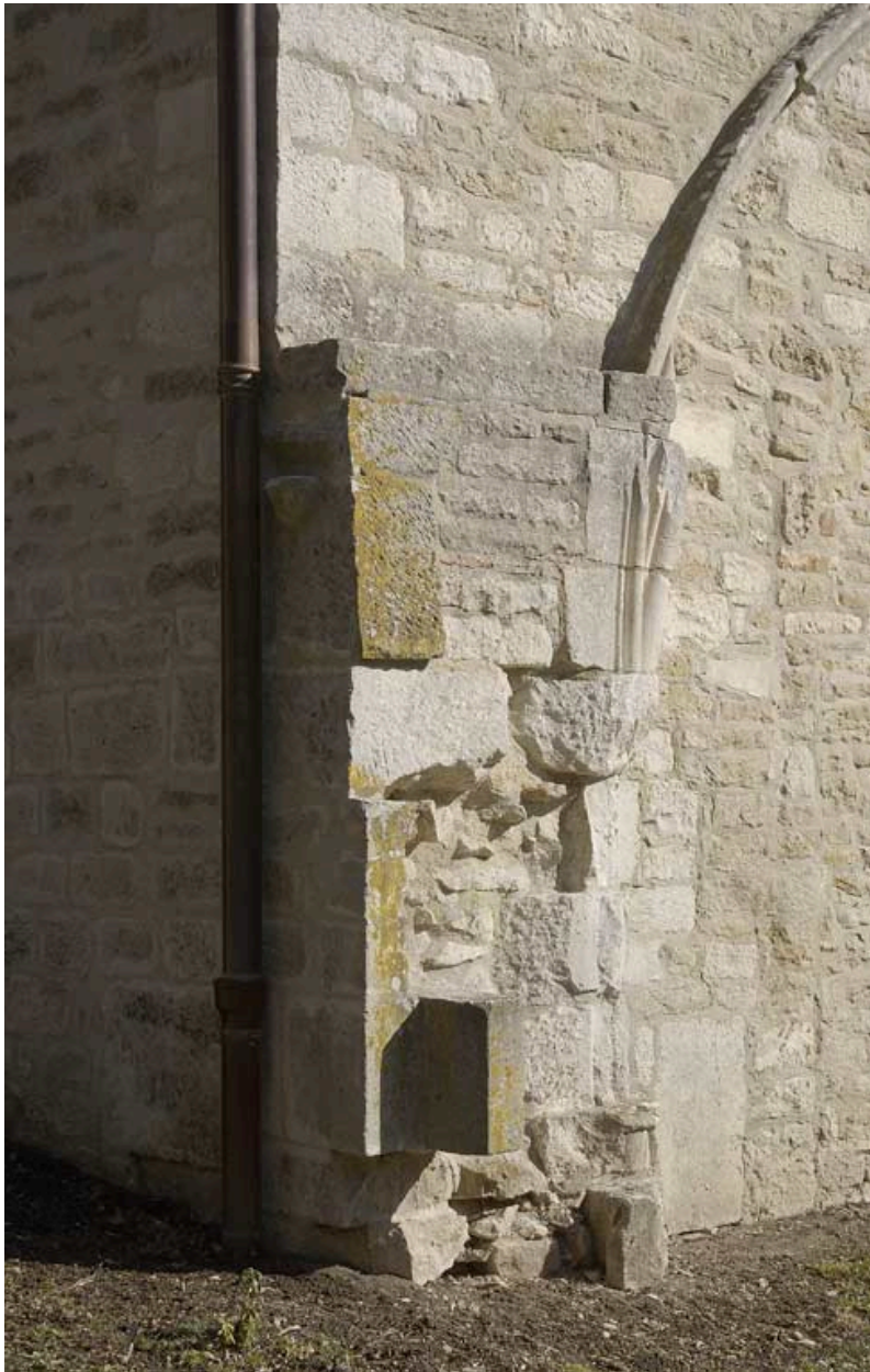
Extrémité nord de l'aile orientale : mur sud, vestiges de la salle capitulaire.
