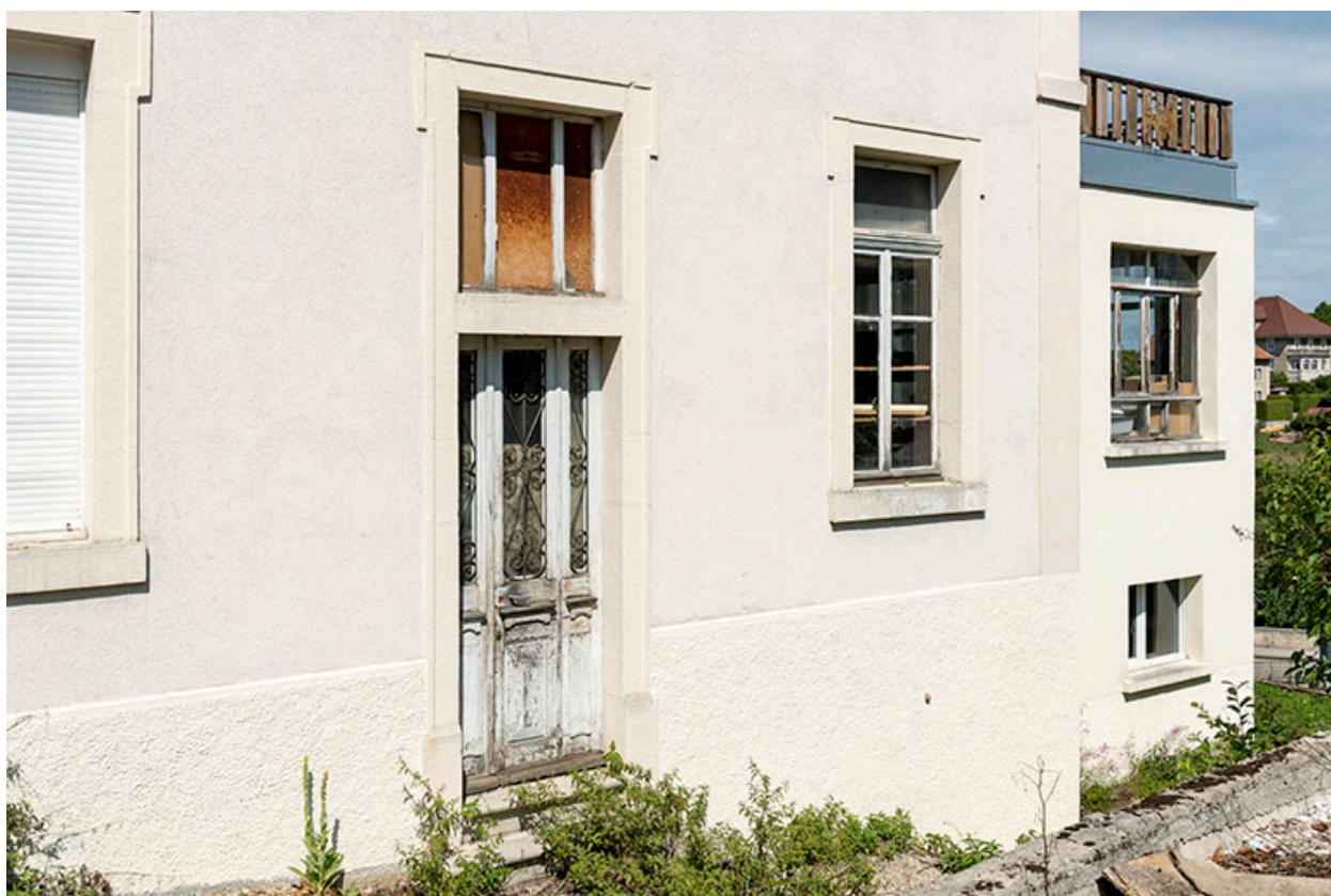
Façade latérale droite : baies du rez-de-chaussée.
