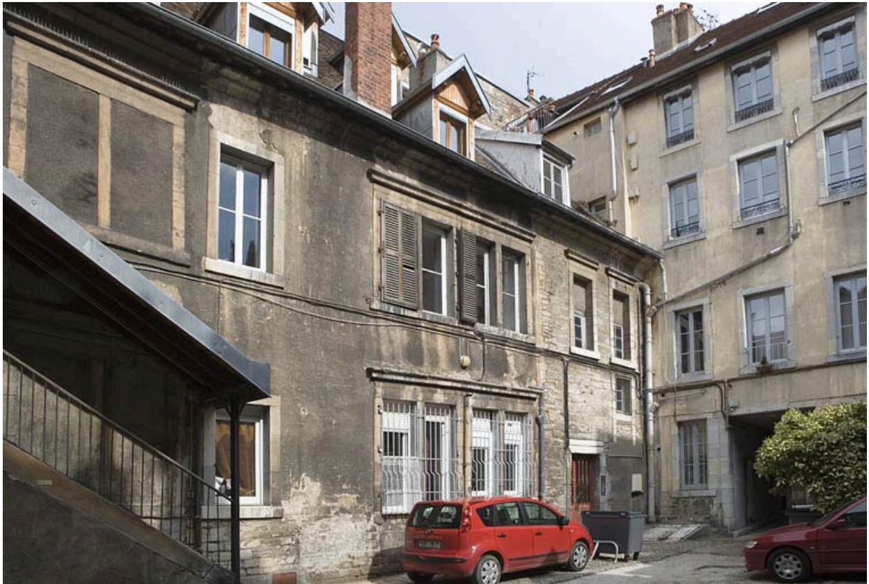
Vue d'ensemble de l'aile sur cour.
