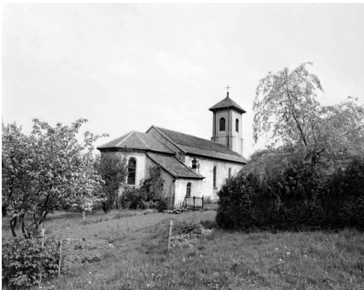
Façade latérale droite et chevet.
