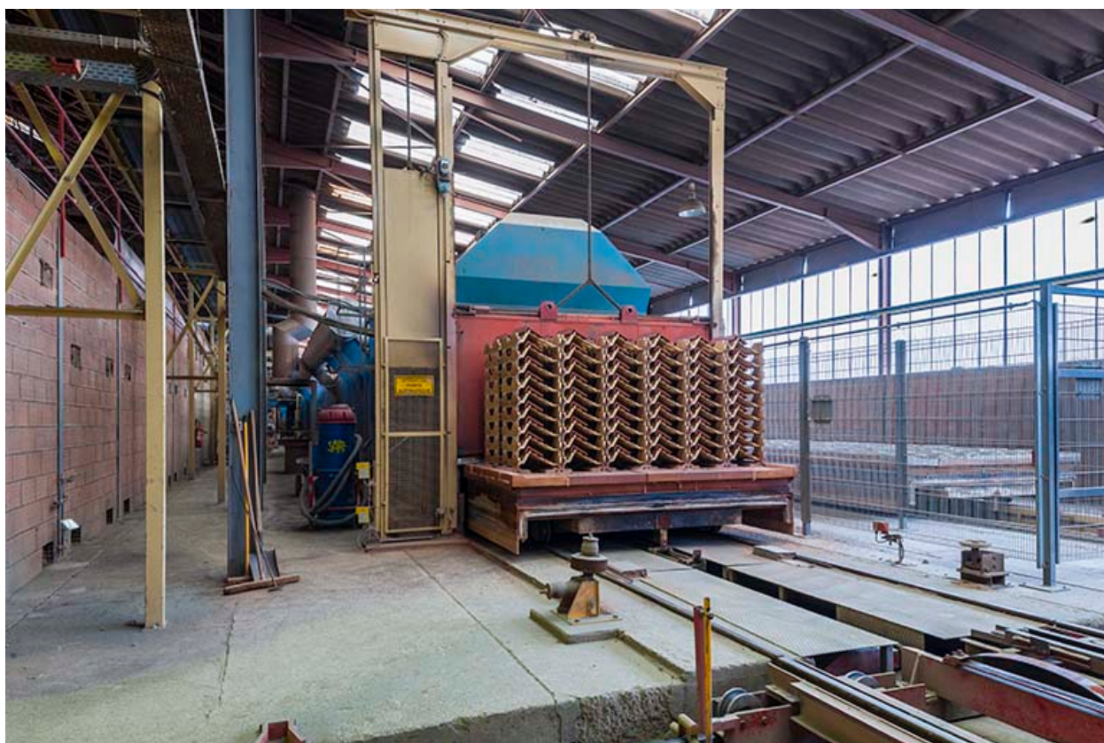
Unité de fabrication dite UL 1. Four (1984).
